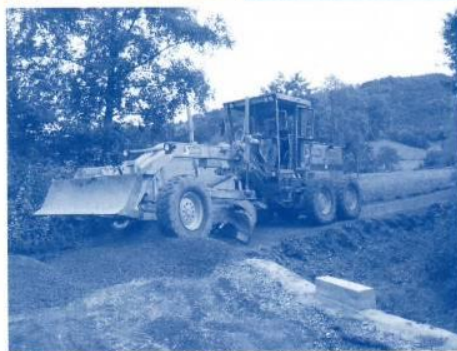
Début des travaux à Cazavet sur la voie communale du Billoc.
