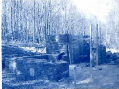
La cabane qui va servir de « point d'accueil » en cours de construction.
